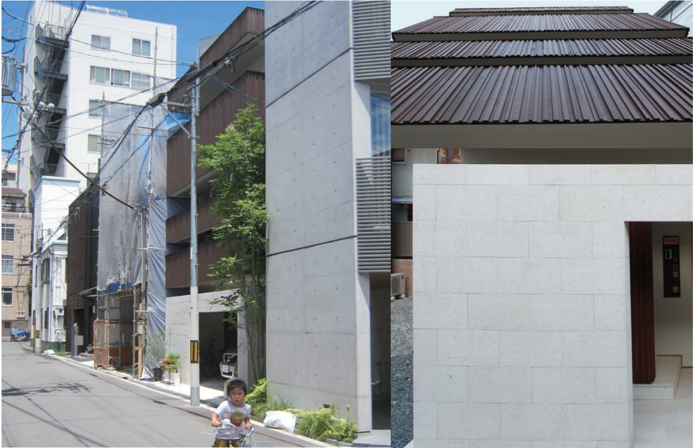
経年変化を楽しむサピ石とレッドシダー貼りの外壁が印象的なファサード
