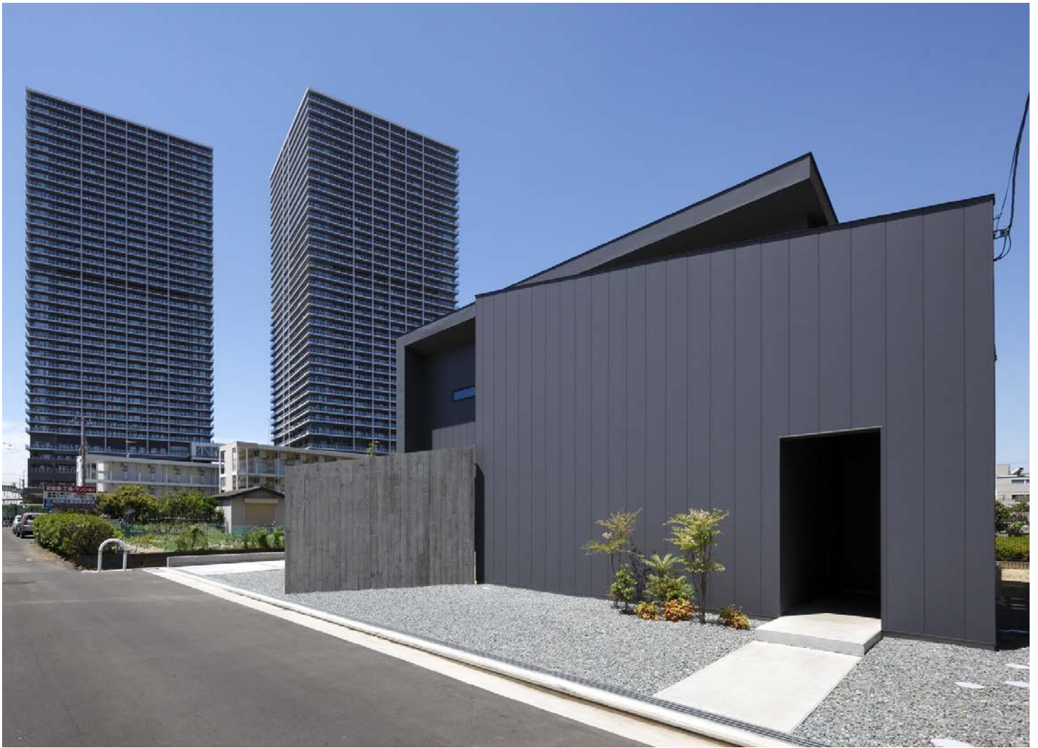
高さの変化があるRC塀と金属サイディングの外観
